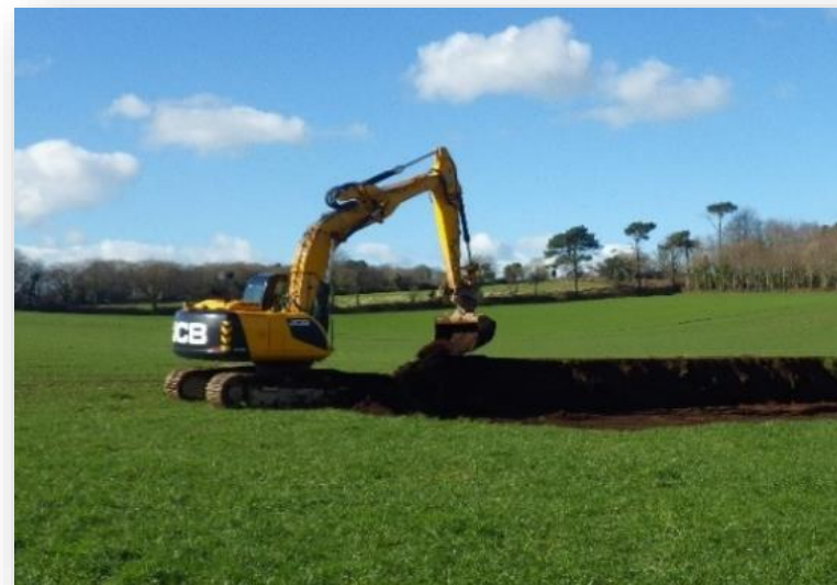
Création d'un talus à la pelle mécanique
