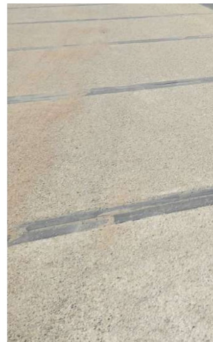
Bordure bois encastrée dans le sol (parking)
