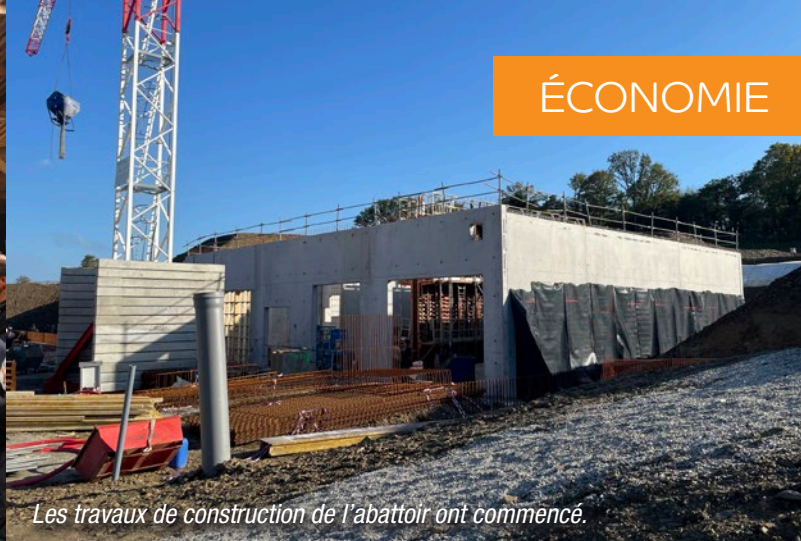
Le 9 juillet 2024, un événement a rassemblé 150 personnes pour marquer le lancement des travaux de l'abattoir.
