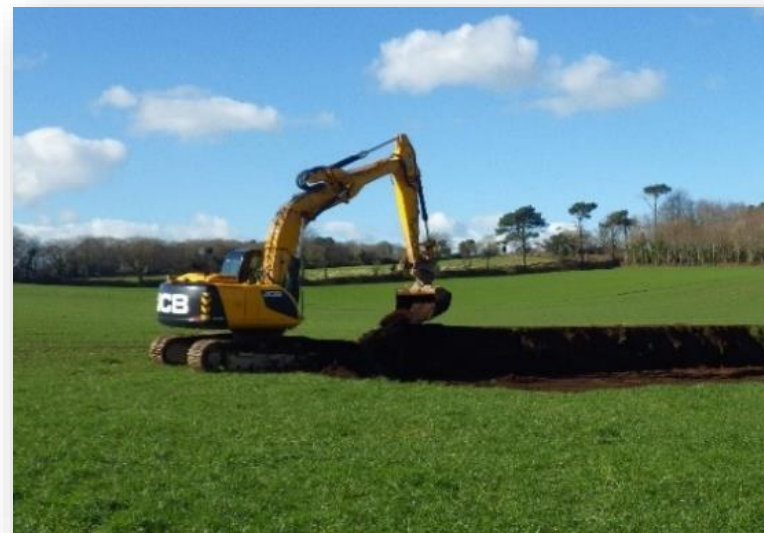
Création d'un talus à la pelle mécanique
