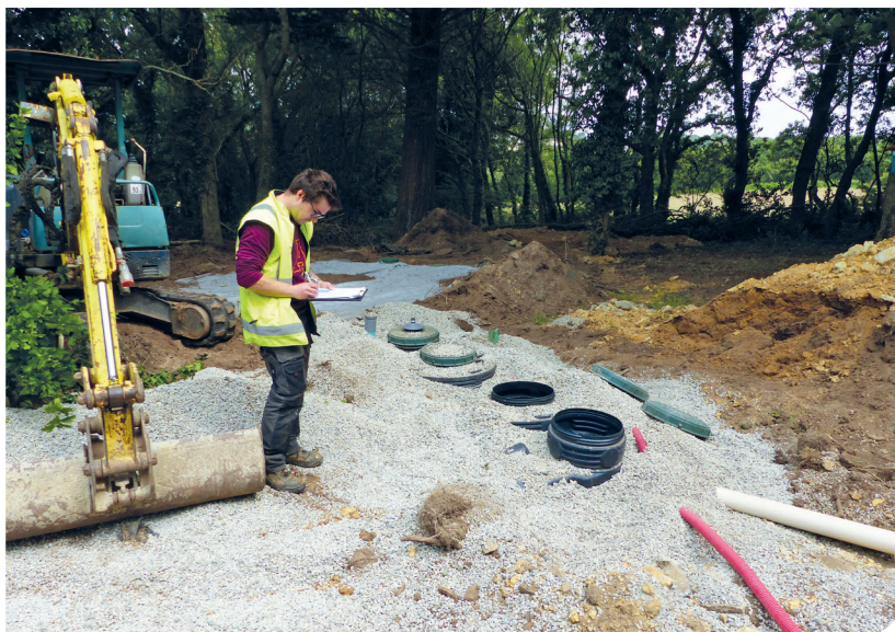
Contrôle de réalisation d'un système d'ANC avant recouvrement
