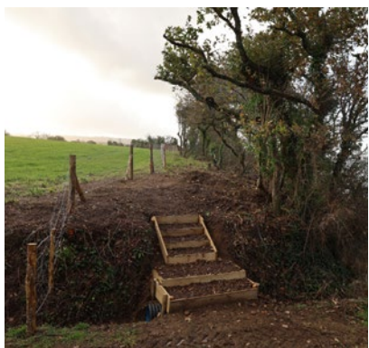
▲ Création d'escalier en régie pour l'aménagement du sentier de Rosnoën
