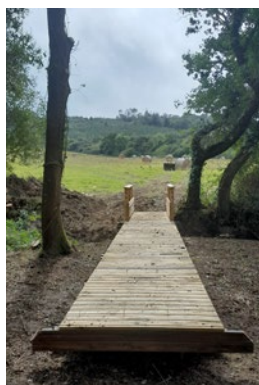
▲ Une des passerelles réalisée à Rosnoën
