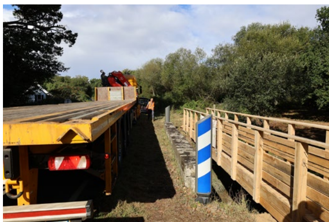
▲ Pose des passerelles (en sous-traitance) sur le sentier de Rosnoën
