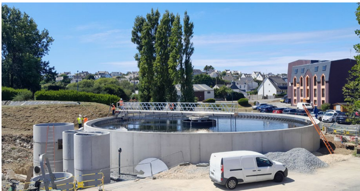
Travaux de modification de la STEP de Camaret-sur-mer.
